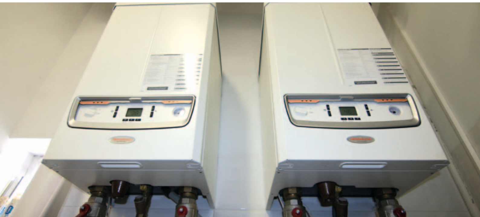
AIR HOTEL, OKĘCIE - kaskada dwóch kotłów wiszących VICTRIX PRO 55 2 ErP
