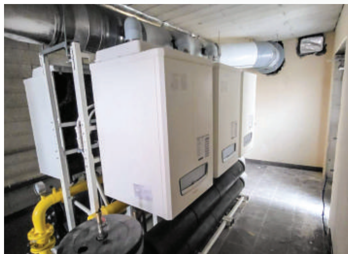
6 x Kocioł Victrix PRO 100 połączone ze sobą w kaskadzie
