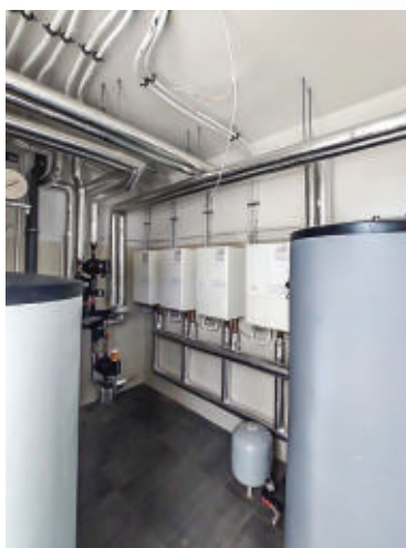
Jednostki wewnętrzne pompy ciepła Magis PRO V2 16 kW
