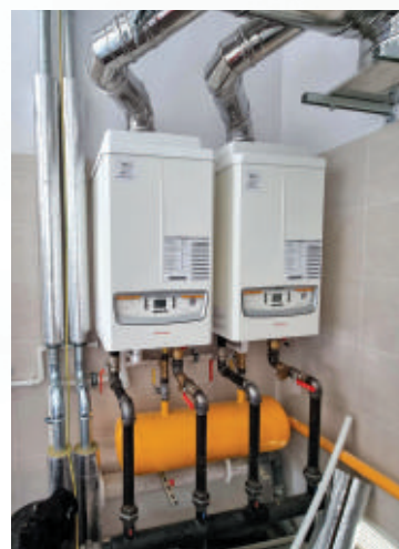
Kocioł Victrix PRO 35 i Kocioł Victrix PRO 55 połączone ze sobą w kaskadzie
