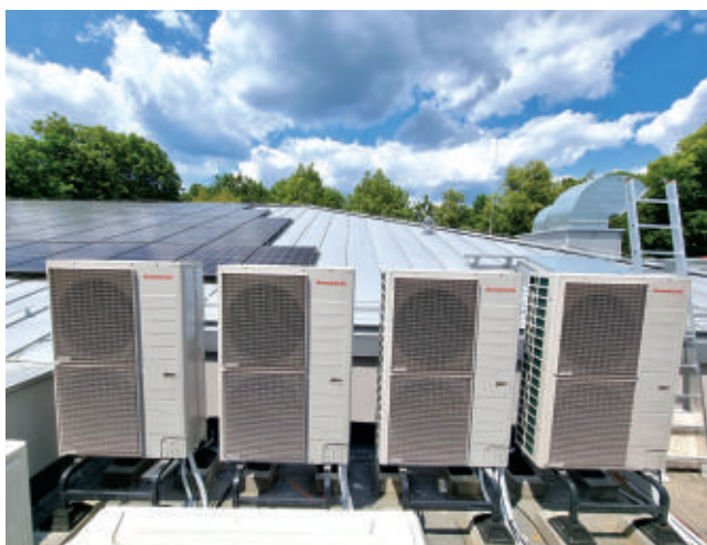
Jednostki zewnętrzne pompy ciepła Magis PRO V2 16 kW
