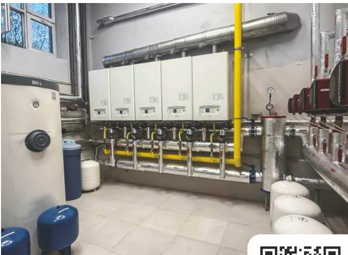
5 x Kocioł Victrix PRO V2 100 EU połączone ze sobą w kaskadzie
